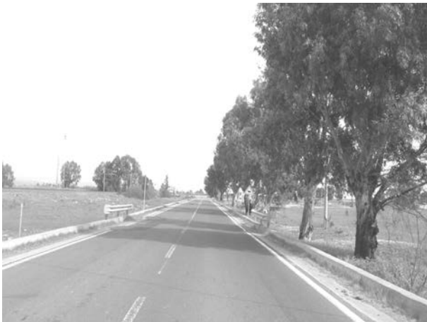
Figura 11 – Tronco stradale sulla S.S. 194 (distanza elevata).
