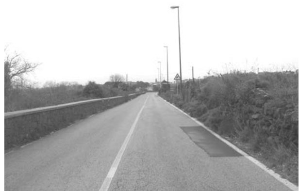
Figura 27 – Tronco stradale sulla S.P. 4/II (distanza elevata).
