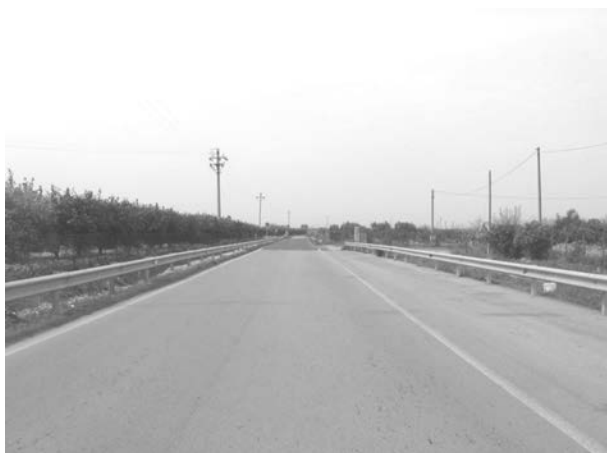
Figura 19 – Tronco stradale sulla S.P. 77 (distanza elevata).
