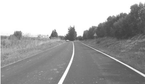
Figura 5 – Tronco stradale sulla S.S. 192 (distanza media).
