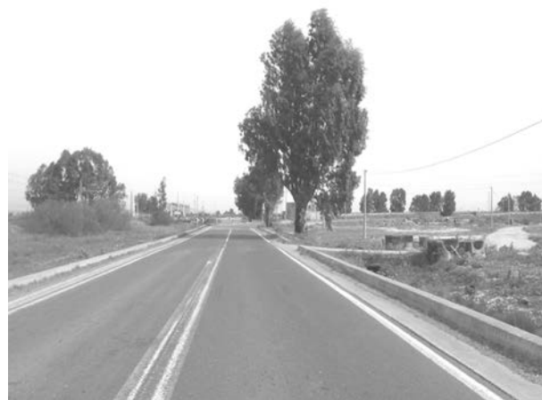
Figura 13 – Tronco stradale sulla S.S. 194 (distanza media).
