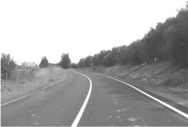
Figura 3 – Tronco stradale sulla S.S. 192 (distanza elevata).
