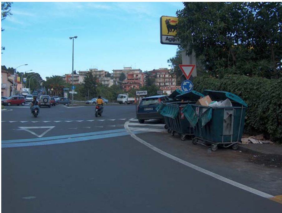
Figura 10. Problemi: segnali verticali semi-nascosti; presenza di segnaletica orizzontale precedente
