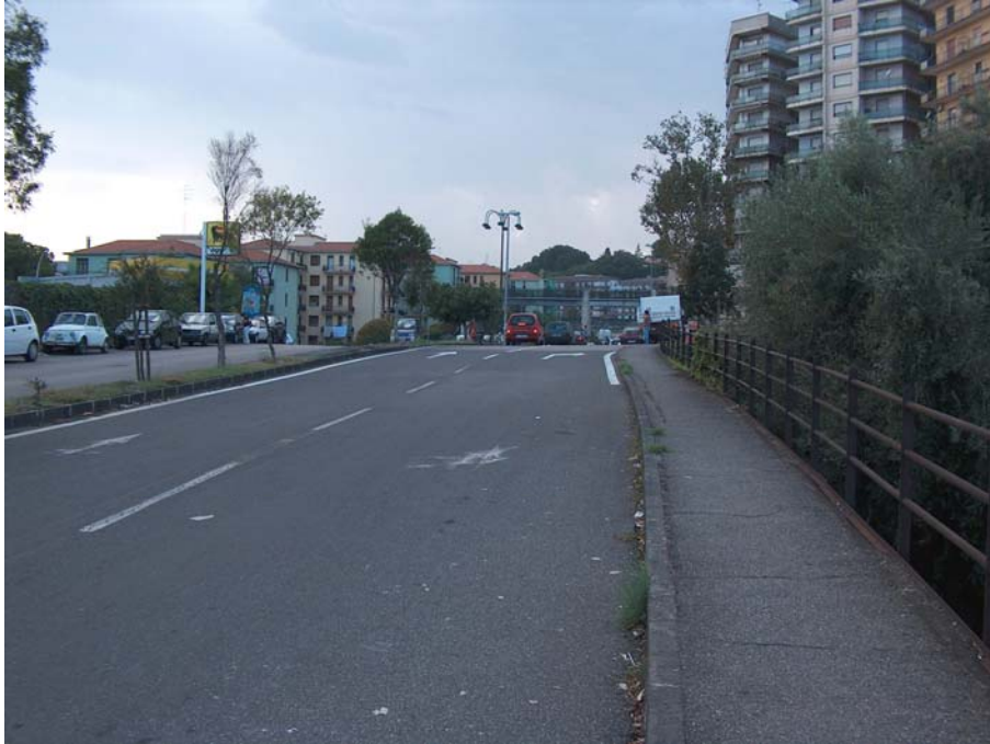
Figura 11. Problemi: assenza di segnaletica verticale; canalizzazioni e segnaletica orizzontale scarsamente visibili
