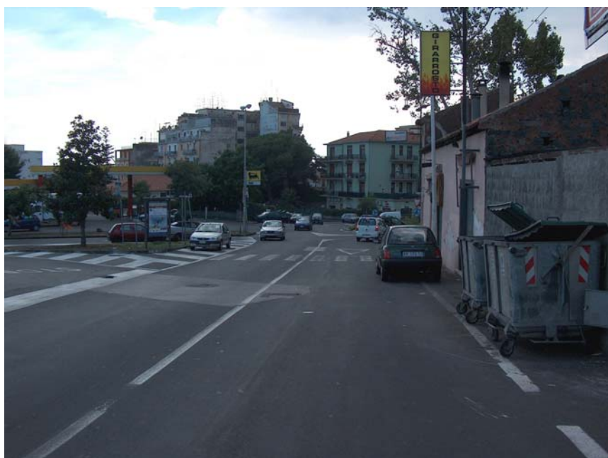
Figura 4. Problemi: segnaletica verticale assente; segnaletica orizzontale sbiadita; ingressi dei fabbricati direttamente sulla carreggiata
