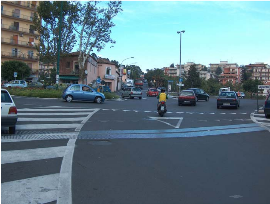
Figura 5. Problema: rotonda decentrata rispetto agli assi delle due direttrici
