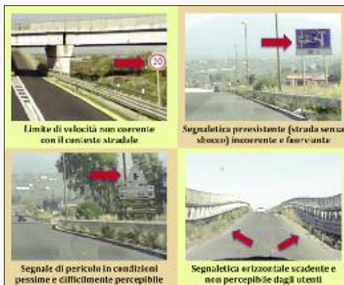
6. Esempi di criticità sussistenti nella segnaletica stradale presente lungo il tracciato in esame
