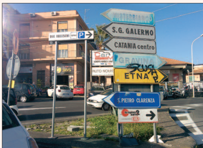
3. Un esempio di segnaletica sovrabbondante e in pessimo stato (causa esogena)
