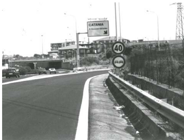
Fig. 27 Posizionamento del segnale di limite massimo di velocità in base al Nuovo Codice della Strada.
