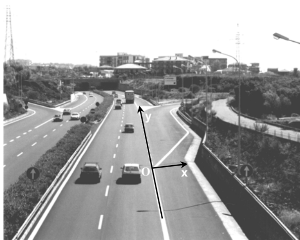
Fig. 7 Visione planimetrica dello svincolo di S. G. Galermo. Viene anche rappresentato il sistema di assi cartesiani utilizzato come riferimento per lo studio delle traiettorie.
