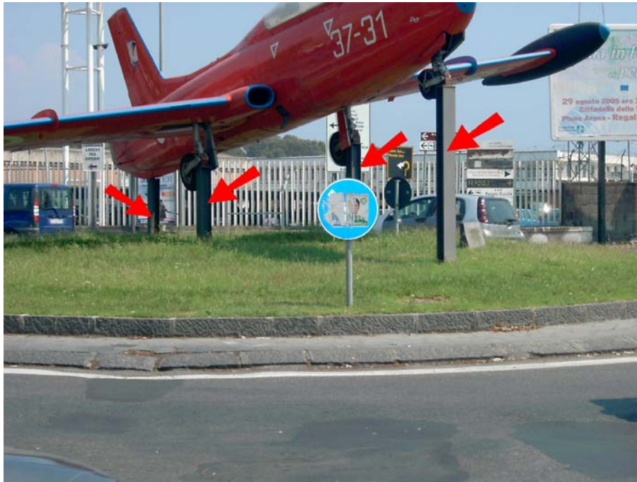
Figura 9. Problema riscontrato: elementi rigidi a sostegno dell'aeroplano (pericolosi in caso di urto veicolare).
