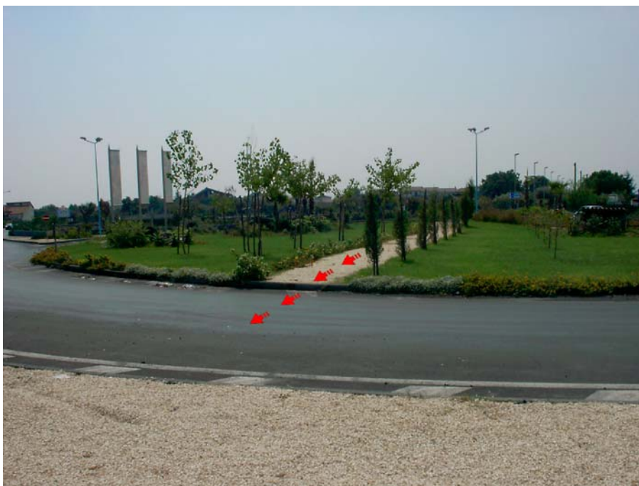
Figura 8. Problema riscontrato: vialetto nell'isola centrale che induce a pericolosi attraversamenti pedonali sulla corona giratoria.
