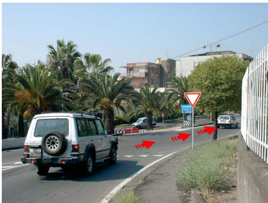
Figura 2. Problema riscontrato: assenza di deflessione per effetto del decentramento dell'isola centrale .
