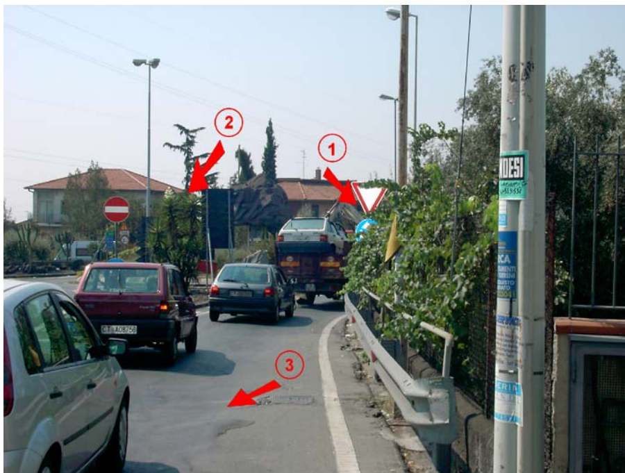
Figura 7. Problemi riscontrati: pannelli segnaletici resi poco visibili dalla vegetazione (1); ostacoli alla visibilità (alberi, cartelli) ubicati sull'isola divisionale (2); difetti di regolarità e scarse condizioni di aderenza superficiale (3).
