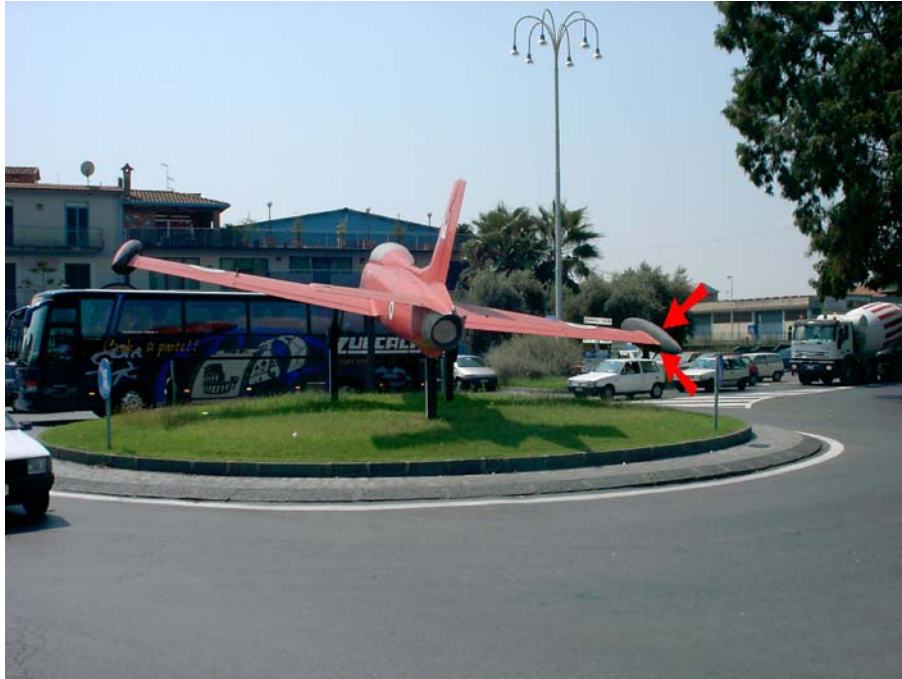
Figura 10. Problema riscontrato: eccessiva sporgenza di un'ala dell'aeroplano. L'ala potrebbe essere urtata dai mezzi pesanti in svolta o in caso di fuoriuscita dalla carreggiata.
