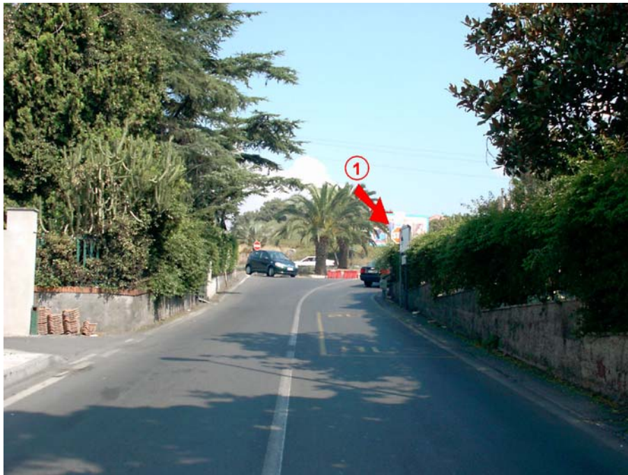
Figura 1. Problemi riscontrati: segnale di STOP poco visibile (1); isola decentrata; assenza di adeguata segnaletica verticale; mancanza di isole divisionali rialzate e di attraversamenti pedonali.
