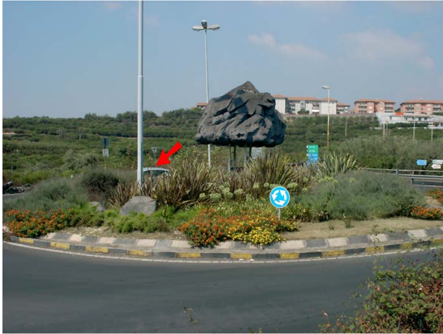
Figura 5. Problema riscontrato: cattiva visibilità prodotta dalla vegetazione presente sull'isola centrale (la freccia indica un veicolo seminascondo dai cespugli) .
