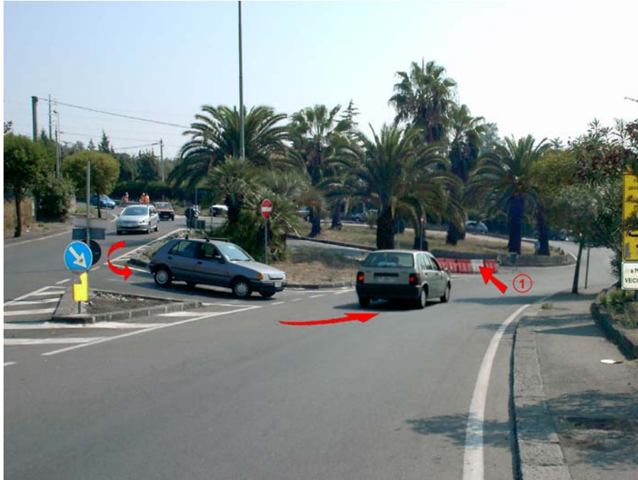
Figura 4. Problema riscontrato: traiettoria anomala per la svolta a sinistra indotta dalla parziale ostruzione della corona giratoria (1) .
