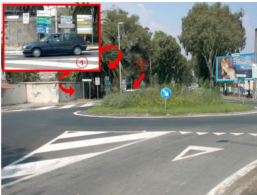
Figura 12. Problemi riscontrati: segnaletica verticale sovrabbondante che può generare confusione ed errori interpretativi da parte degli utenti (1); fitta vegetazione sull'isola centrale con conseguente occultamento dei veicoli in circolo (2).
