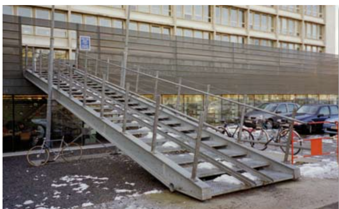
Figura 2.41 Scale con canaline.
